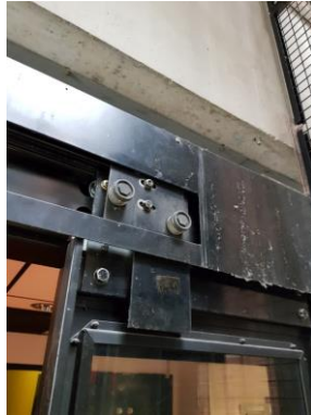
Serrure de porte palière du niveau principal
